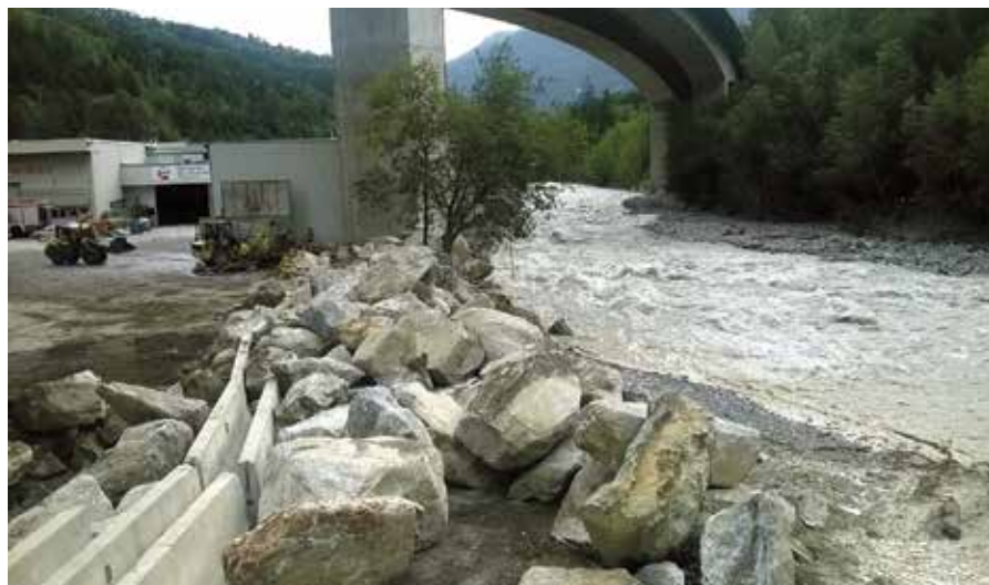
Bis zur Errichtung des regulären Hochwasserschutzes soll eine temporäre Maßnahme die Firma Wille schützen.
